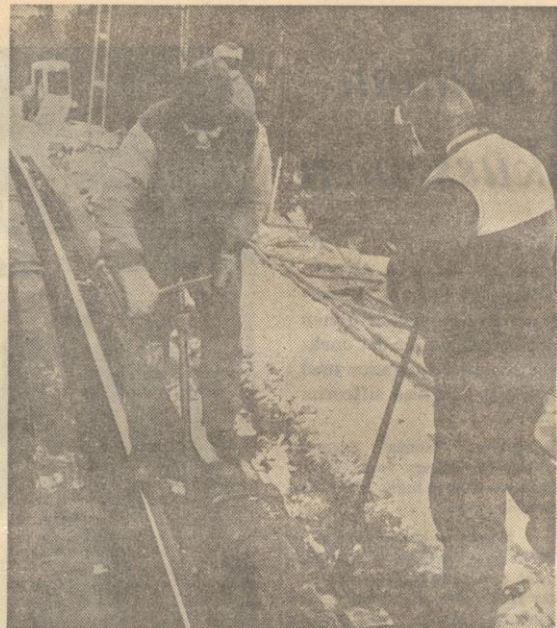
Herman Jönskog, Nyåker, i färd med att bulka fast rälsbryggan. Rune Lindgren, Orrböle, håller den i läge.
